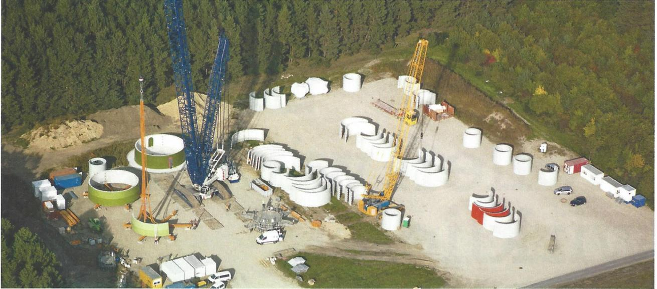
Der Windkraftanlagenhersteller JUWI gibt pro Anlage ca. 8000 – 10 000 m<sup>2</sup> Flächenverbrauch an. Hinzu kommen die Zuwege für Schwerlasttransporter (bis zu 20 m breit). Ausserdem Kurvenradien mit bis zu 60 m, somit ca. 1500 m<sup>2</sup> für jede einzelne Wegabzweigung sowie Wende- und Lagerbereiche. Ein Rotorblatt wiegt fast 26 000 kg, mit dem LKW sind das über 44 000 kg.
