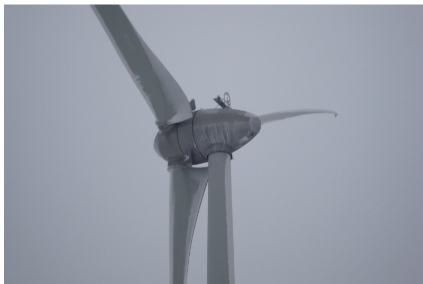
Abb. 28: WEA 1 mit abgeschalteter Blattheizung und vereisten Rotorblättern.
