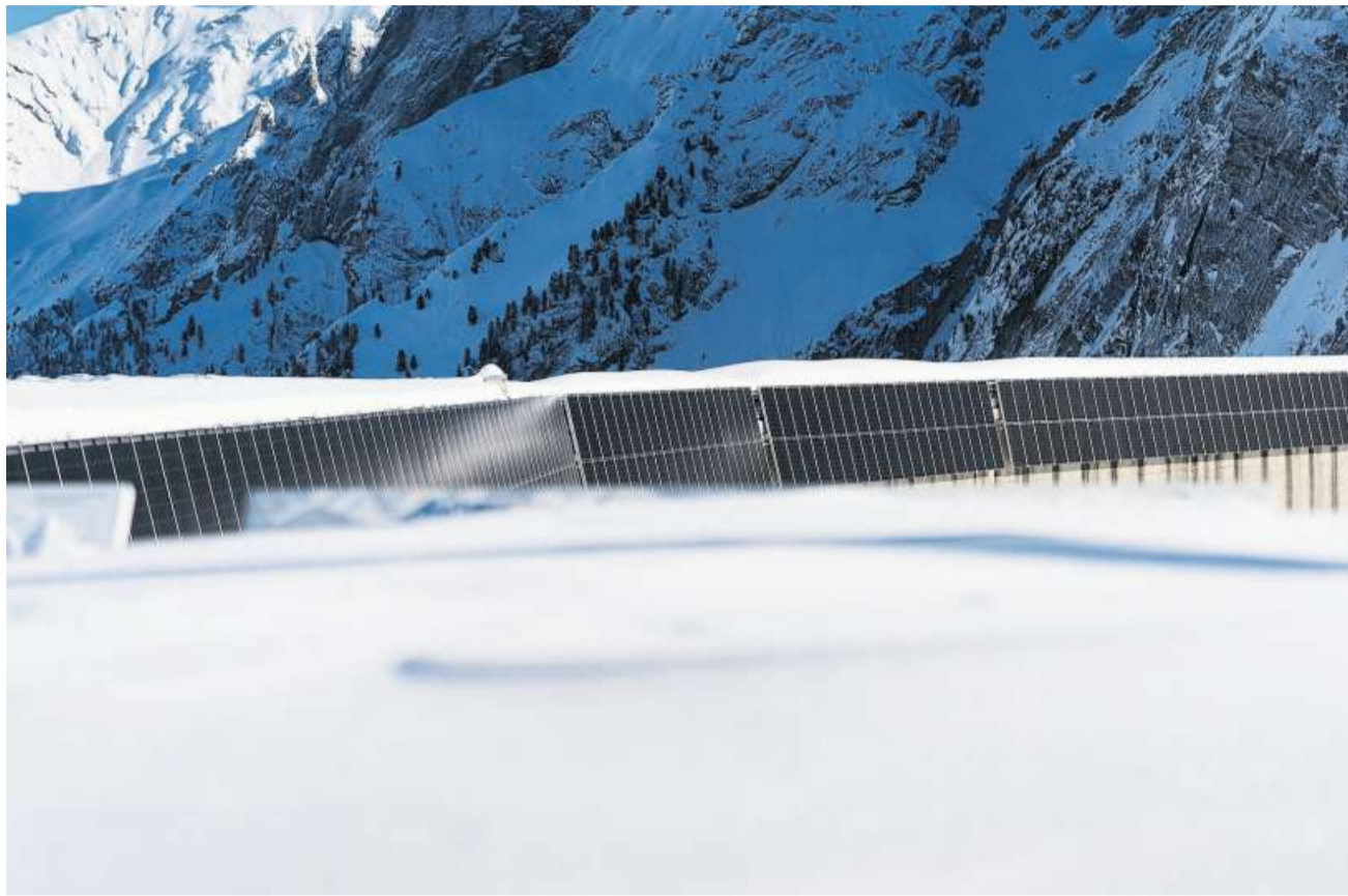
Die Solaranlage an der Albigna-Staumauer im Bergell nützt die vielen sonnigen Wintertage am Alpensüdhang. GAËTAN BALLY / KEYSTONE
