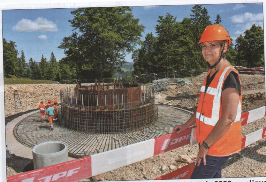
Florence Schmidt, ingénieure et cheffe du projet depuis 2008, explique les différentes phases pour la réalisation d'un socle.
