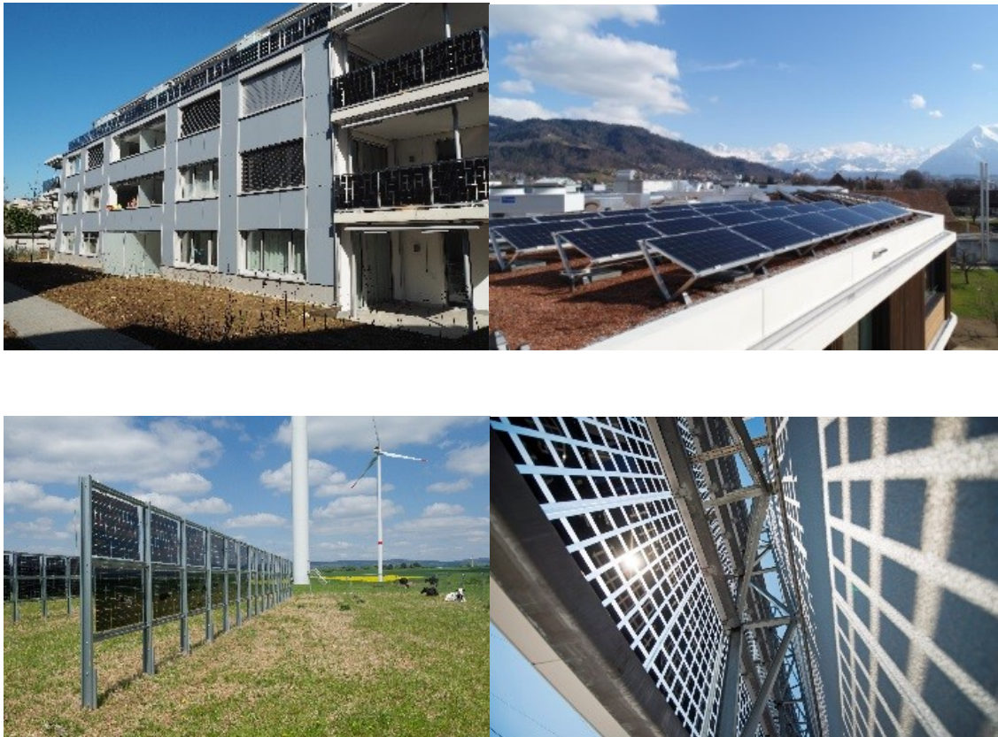
Abbildung 14: Vielzählige Anwendungsmöglichkeiten bieten sich für den Einsatz bifazialer Solarmodule an: oben (v.l.n.r.): 3kWp-Terassengeländer an MFH in ZH Oerlikon, 101kWp-Dachanlage in Steffisburg, 3S Solar Plus,
