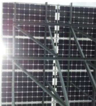
Abbildung 18: Bifaziale Solarmodule an einem nicht geeigneten Montagesystem. Die Verschattungen durch Trägerprofile mindern den Energieertrag der Modul-Rückseite, Quelle; renewable energy world
