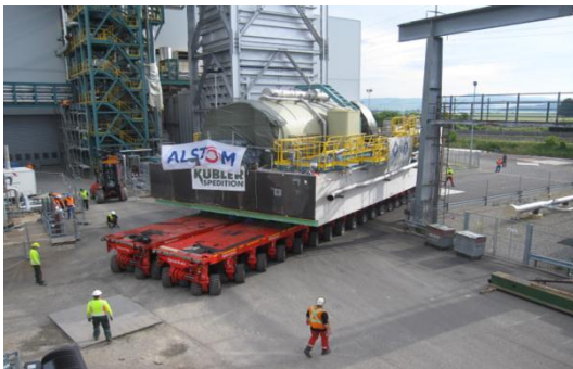
Abbildung 5: Umzug des Frequenzumrichters und Generators nach Birr-4
